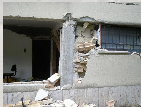
negativan utjecaj ispuna na potresni odziv konstrukcije , L'Aquila, 2009
