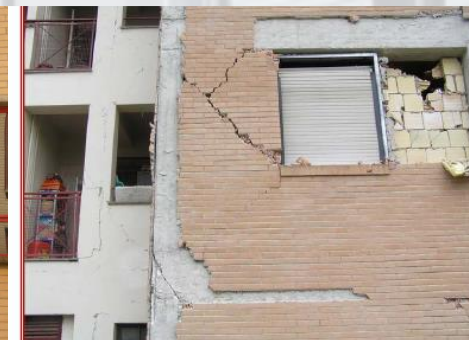
oštećenja zidnog ispuna, L'Aquila, 2009
