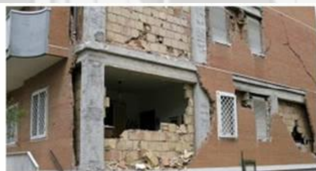
sлом "kratkog" stupa, Wenchuan, 2008 slom zida van ravnine, L'Aquila, 2009
