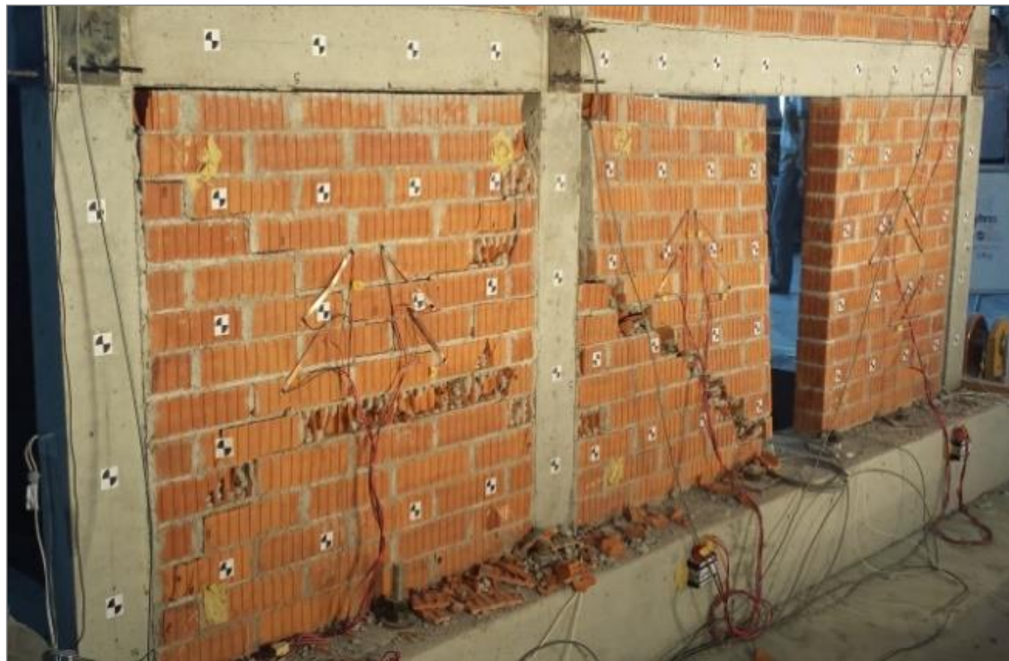
Pukotinske linije na ispunu modela 1 - konačno
