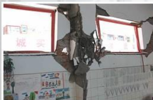
sлом "kratkog" stupa, Wenchuan, 2008 slom zida van ravnine, L'Aquila, 2009
