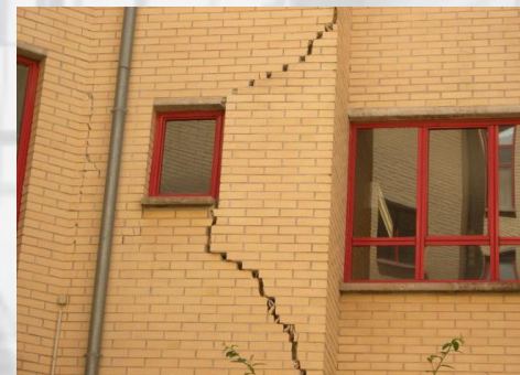
oštećenja zidnog ispuna, L'Aquila, 2009
