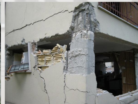
negativan utjecaj ispuna na potresni odziv konstrukcije , L'Aquila, 2009
